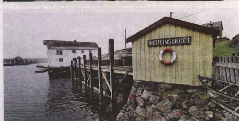
Unike Ansteinsundet: Den nye kaia til Jan H. Hovde er anlagt 75 cm høyere enn Jonbrygga – dette er i strid med bebyggelsesplanen for det gamle fiskeværer. Han startet byggingen før han søkte. Nå er det byggestopp.
