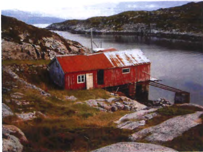
Figur 1; Brygge med bygning før tiltak
