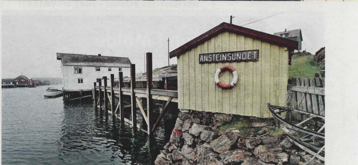
Unike Ansteinsundet: Den nye kaia til Jan H. Hovde er anlagt 75 cm høyere enn Jonbrygga – dette er i strid med bebyggelsesplanen for det gamle fiskeværret. Han startet byggingen før han søkte. Nå er det byggestopp.
